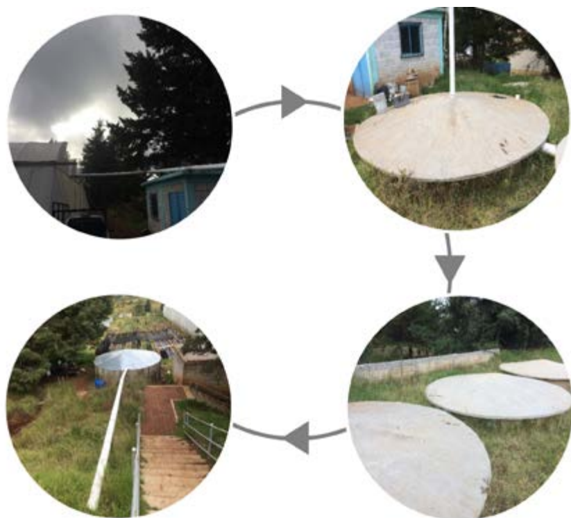
Figura 2. Sistema de captación de agua de lluvia
