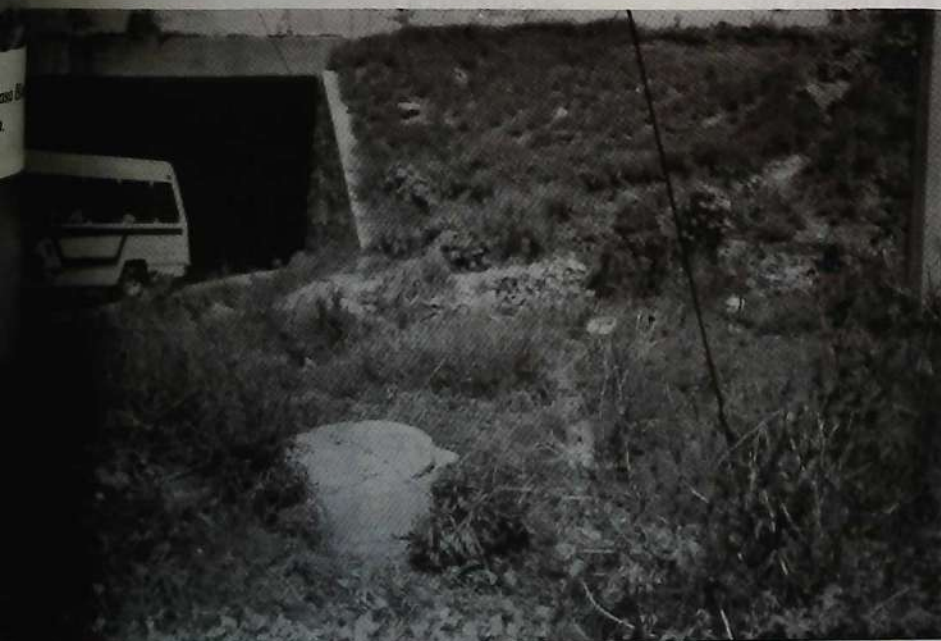
ON° 8 Puente alcantarilla donde actualmente pasan los escurrimientos del arroyo El Tángano, a falta de una estructura de encausamiento al Cimatarío I.
